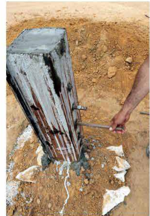
Após cada balde de concreto precisa socar o concreto.
