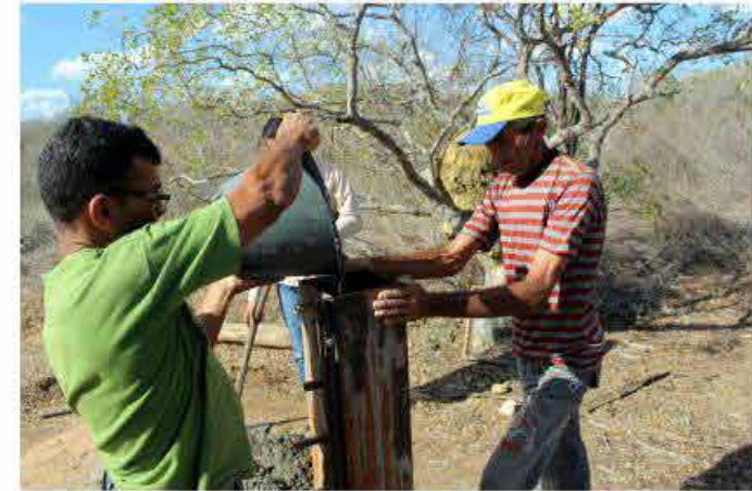
Após cada balde de concreto precisa socar o concreto.
