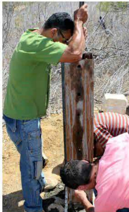
Uso de um vergalhão ou ripa ajuda o concreto penetrar em brechas.
