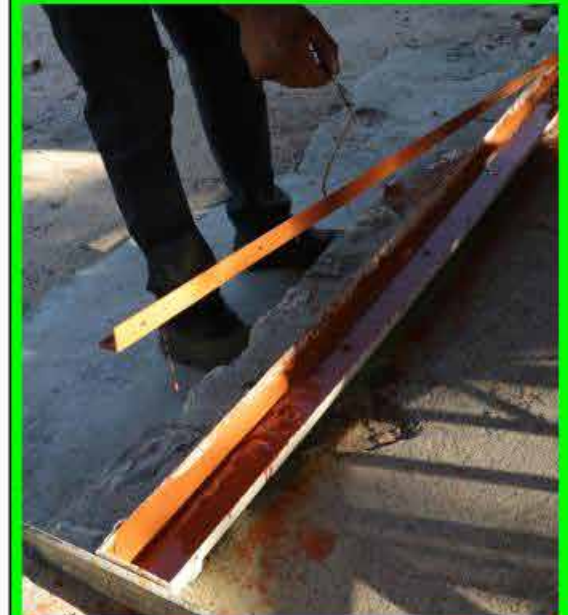
Pintura das estacas por imersão
