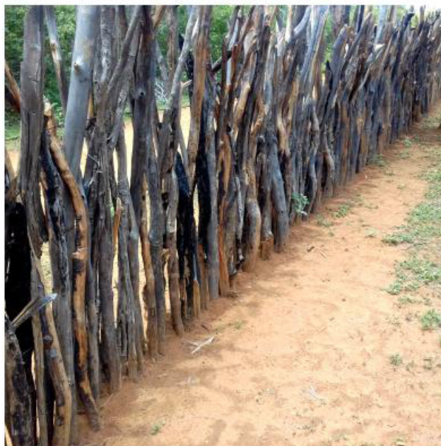
Cerca faxina, com dois fios de arame farpado: se percebe que todas as madeiras são firmemente enterradas no chão, acelerando assim sua decomposição em contato com a macro e micro vida do solo.
