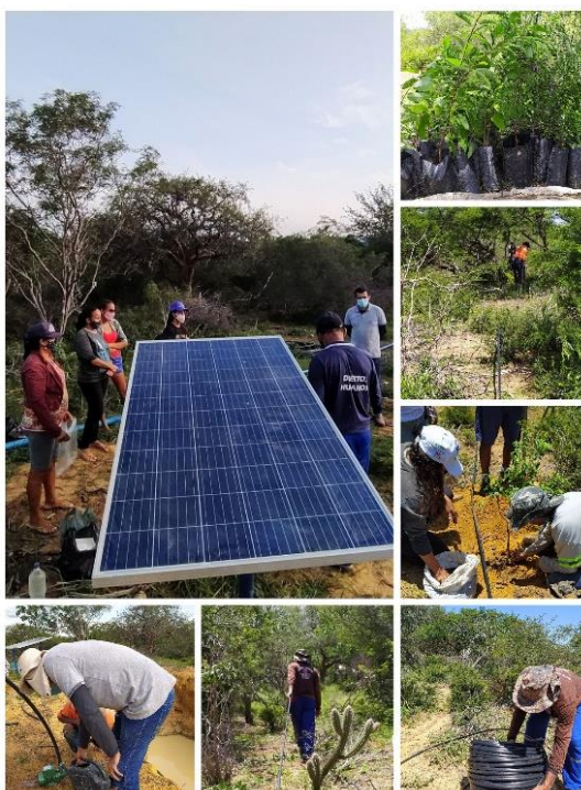
Figura 23: Atividades de instalação do SAF
